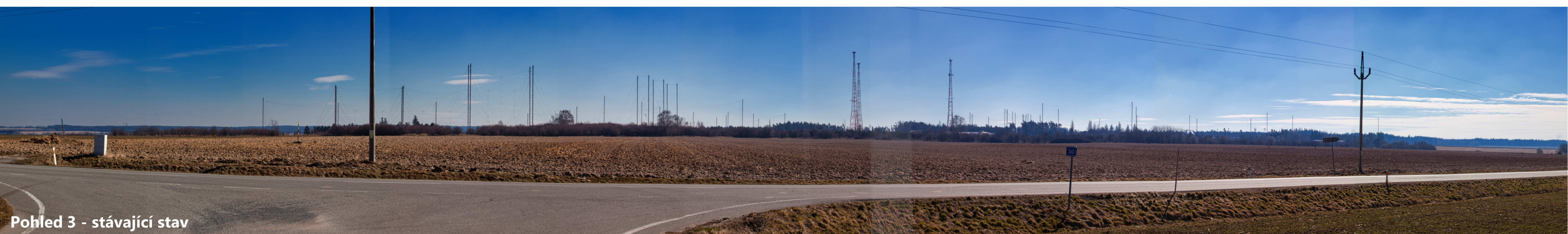
Pohled 3 - stávající stav
