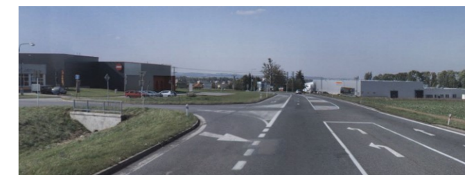
Vyústění ul. Průmyslová na silnici I/35.
