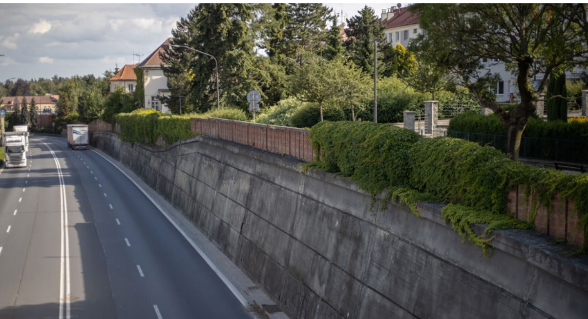
Nosič: prefabrikátová zeď podél silnice I/35
