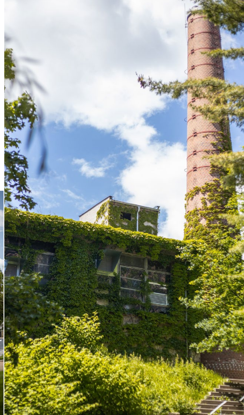
Nosič: cihlový komín, fasáda budovy Kotelny
