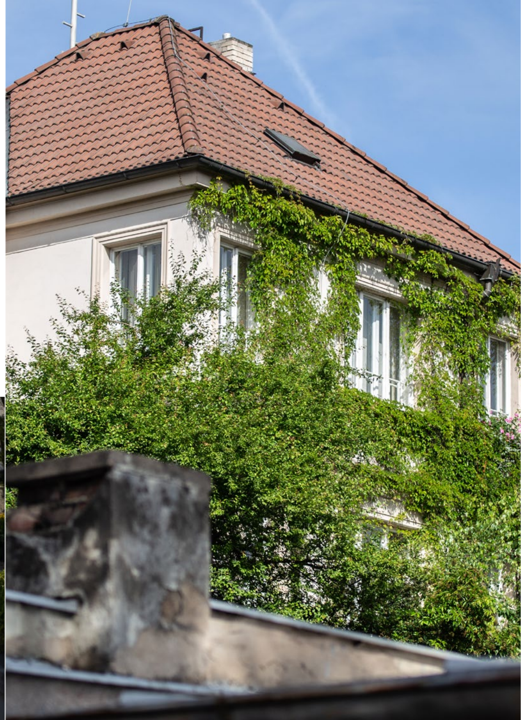
Nosič: fasáda budovy MěÚ
