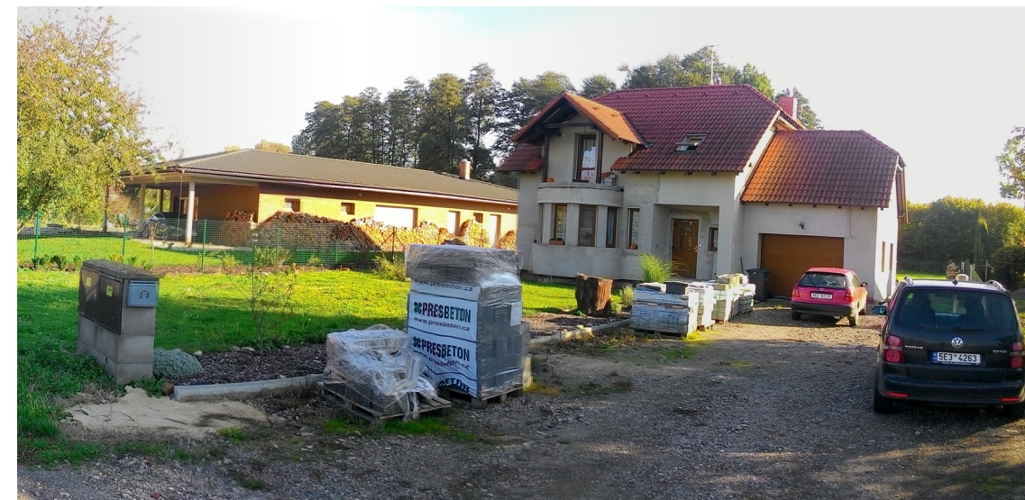
Lokalita „Nedošín“ - pohled z komunikace jižním směrem (nekoncepční zastavění jižní strany ulice)
