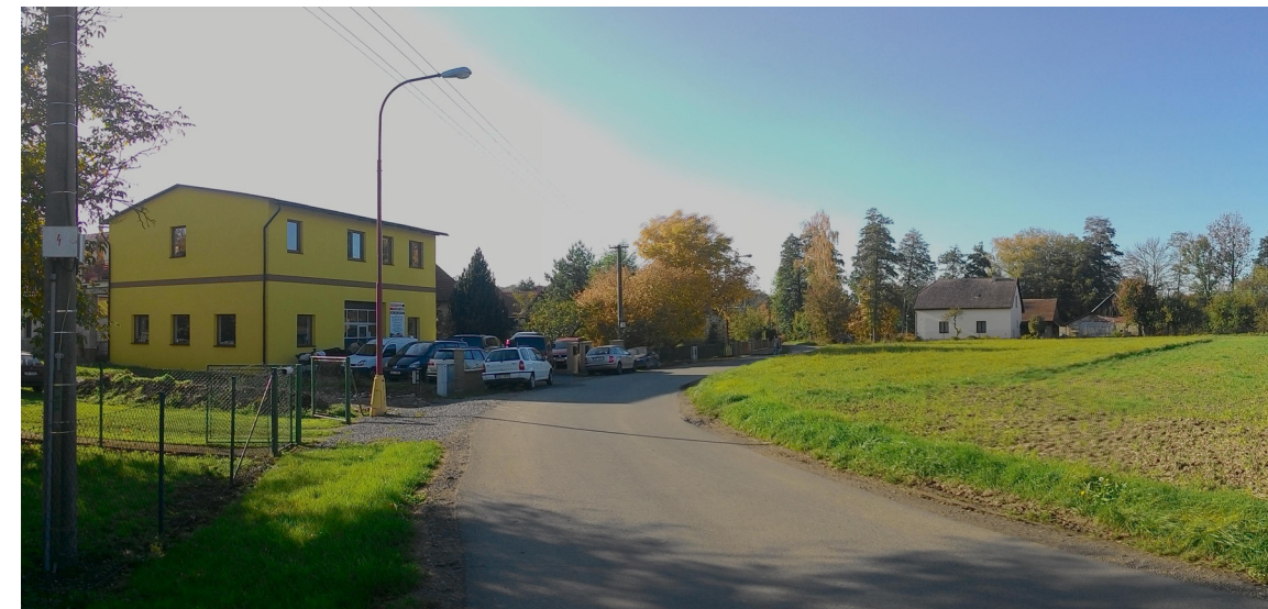
Lokalita „Nedošín“ - pohled z komunikace západním směrem (nekoncepční zastavění jižní strany ulice je patrné vlevo)
