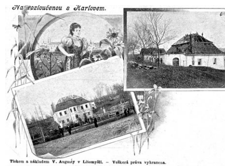
Hostinec Karlov, v jehož sále se konaly společenské akce. Ustoupil stavbě Smetanova domu.
