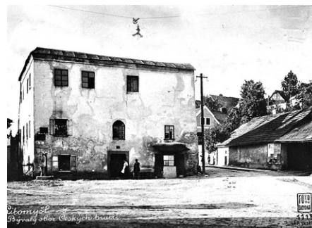
Bratrský dům, který stával poblíž Smutného mostu v prostoru dnešního hotelu Dalibor, odstraněn v roce 1928.
