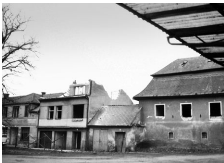
Pohled na budovu tzv. Mícelky, bývalé první kavárny ve městě. Vlevo pak truhlářství a kopytárna.
