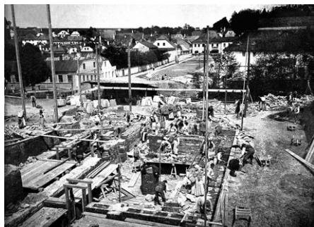
Budování základů Smetanova domu v roce 1903
