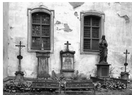
Místo u zdi kostela sv. Anny – hroby v těchto místech byly z hlediska sanace zdi přemístěny.
