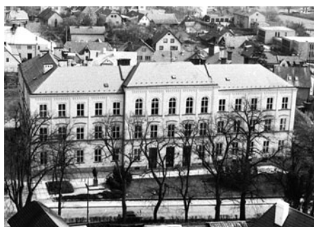
Bývalá chlapecká škola po rekonstrukci stále slouží svému účelu.
