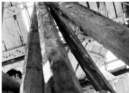
Vyměňovaly se také hlavní trámy věže kostela.
