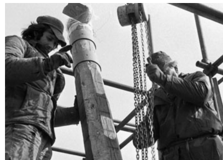
Úprava kování na hlavním sloupu věže
