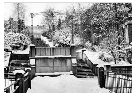
Z náměstí vedlo na Masarykovu čtvrť výstavné schodiště. Dnes je ukončeno betonovou lávkou nad průchozí silnicí.
