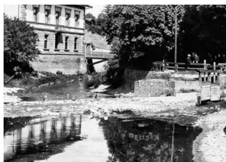
Splav u hostince Za vodou zvedal vodu do kanálu, který vedl až k vlastnímu mlýnu a pak pokračoval do Loučné zahradami Havlíčkovy ulice a Bernardky.
