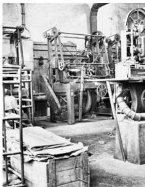
Toto je stroj, který kopíroval vzor kopyta na připravený polotovár.
