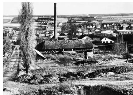
Pohled na družstevní cihelnu při silnici na Morašice.
