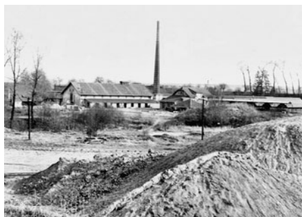
Bývalá cihelna a hlinišť směrem k Osíku, dnes sídlo městských služeb.
