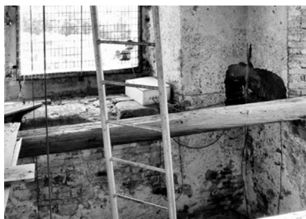
Věžní otvory do náměstí jsou zakryty pletivem proti náletům ptáků.
