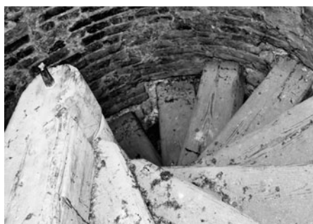
K hlavní části věže vede točité starobylé schodiště.
