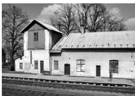
Pohled na budovu výtopny a na napájení vodou
