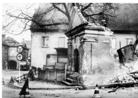
Bourání kapličky na křižovatce U Wagnerů
