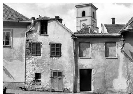
Snímek z Toulouvcova náměstí dokazuje, že se dosud za celou dobu dodnes nepodařilo opravit zchátralou budovu.
