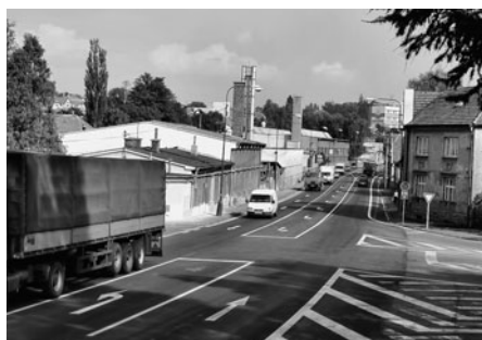
Tato ulice je nejvíce zatíženou částí automobilového průtahu.
