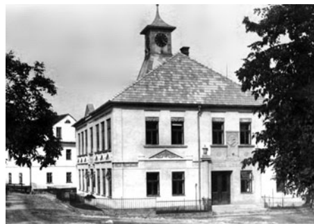
Budova školy v Morašicích, jak vypadala kdysi.
