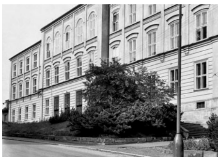
Zahrádky byly odstraněny v roce 1960 a škola dostala novou fasádu.
