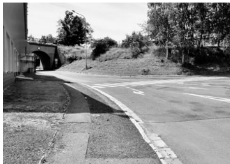
U viaduktu (od R35) – Pro tuto lokalitu byla dohodnuta sdružená investice firmy provádějící v minulosti výkopové práce a pana Svatoše, který vlastní přilehlý objekt. Tato investice bude spojená s rekonstrukcí ploch v jeho vlastnictví.
