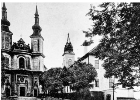
Původní fasáda barokního chrámu a budova bývalého gymnázia.
