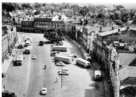
Na náměstí bylo v minulém století také místo pro odjíždějící autobusy, později se stanoviště autobusů přemístila na Bělidla.
