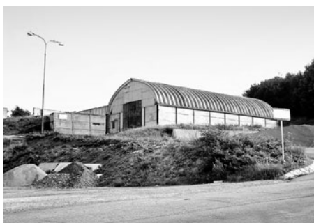
Prostory cihelny v horní části jsou dnes sídlem Správy a údržby silnic Pardubického kraje.
