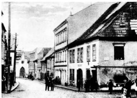
U Kábrtů – Havlíčkova ulice – zbouráno
