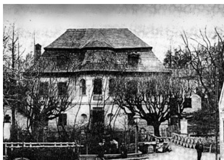
Na Karlově – před postavením Smet. domu – zbouráno
