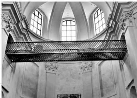
V piaristickém kostele byla na konci února instalována lávka spojující východní emporu s oratoří. Propojením těchto dvou prostor vzniká souvislá komunikační linie, která bude sloužit k umístění expozice arcidiecézního muzea. Lávka je jedinečnou prostorovou kovovou konstrukcí s podlahou z dubových fošen a zábradlím tvořeným diagonálními lamelami. foto Antonín Dokoupil
