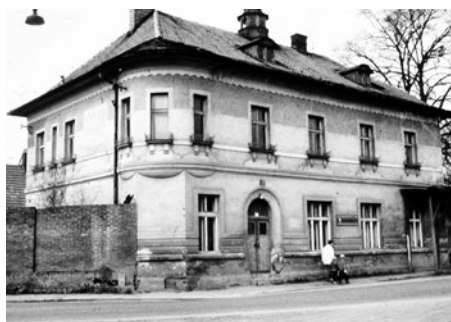
Na Růžku – světelná křižovatka – zbouráno
