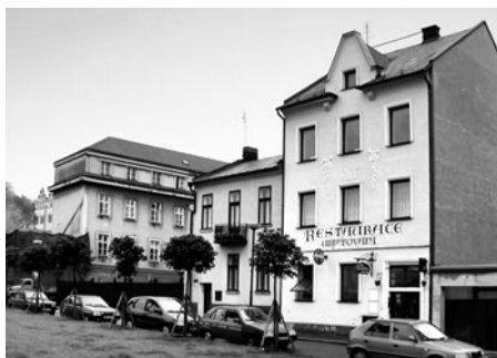
Hotel a restaurace Růže sloužily do padesátých let. Potom zde byly jen kanceláře. V provozu byl opět v devadesátých letech, dnes je znovu uzavřen.
