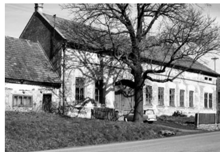
Zanedbaný objekt v sobě skrývá bývalou strojírnu na motory a hospodářská zařízení z první poloviny 20. století.
