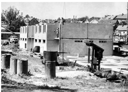
První základy a stavby ještě neprokazovaly jejich budoucí výšku.
