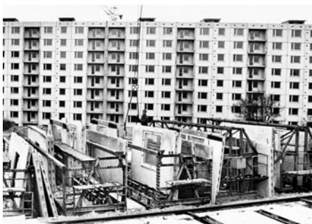
Velký prostor staveniště představoval trvalý přísun stavebních panelů a dalšího materiálu.
