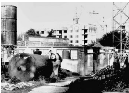
Stavba byla na velké ploše, kde převládal stavební ruch a velká technika.
