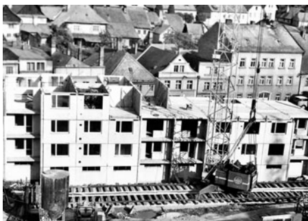
Tyto stavby již prozrazují, jak bude vypadat nová Havlíčková ulice.
