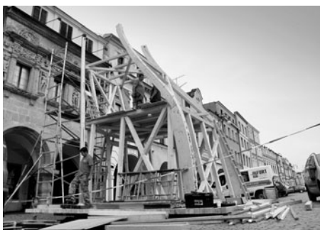
Před domem U Rytířů vyrostla 4. června Perská věž architekta Zdeňka Fránka, mj. autora Nového kostela Církev bratrské v Litomyšli. Dřevěnou konstrukci zakryje v příštích dnech futuristický „zrcadlový kabát“, který zdůrazní orientální charakter stavby. Lidé, kteří po schodech vystupují až na její vrchol, budou moci pohlédnout postavám rytířů přímo do tváře. Věž je jednou z částí autorova cyklu s názvem Útroby architektury. V Litomyšli bude instalována až do skončení Fránkova výstavy v Městské galerii (do 2. 12. 2012).
