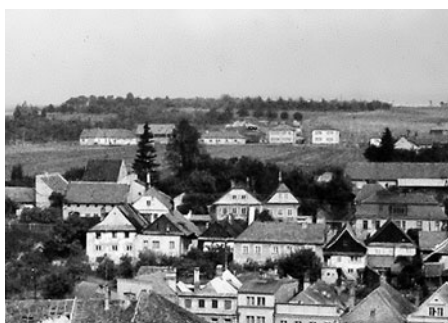
Na Zahájí měli hospodáři svá políčka nedaleko. Dokládá to snímek, kde jsou volné plochy polí mezi Tomičkovou a Družstevní ulicí.
