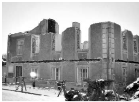
Vila před a během rekonstrukce.
