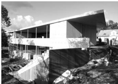
Již zastřešený nový kostel.
