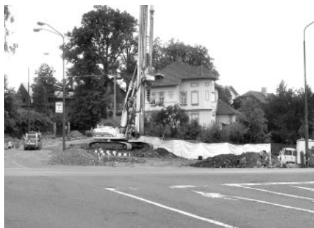
V místě připravované křižovatky panuje čilý stavební ruch.
