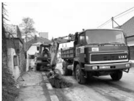
Po ukončení objížďné trasy se ulice Na Lánech projíždějícím vozidlům uzavřela a začaly nezbytné opravy komunikace, ale také inženýrských sítí pod jejím povrchem.
