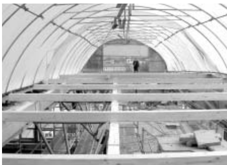
Oprava poškozené střechy sportovní haly si vyžádala náročnou technickou řešení.
