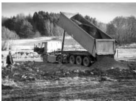
Stavba nového parkoviště.
