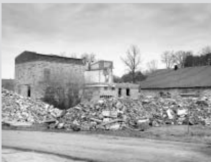
Starý objekt hostince byl téměř zničen...
