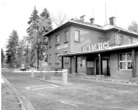
Nový vjezd do areálu Nemocnice s elektronickým systémem.
