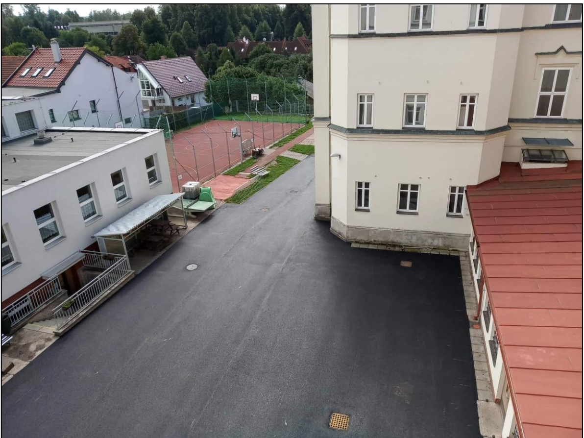
Nový asfaltový povrch na školním dvoře položený v závěru hlavních prázdnin
